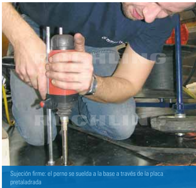
Sistema de fijación de pernos
