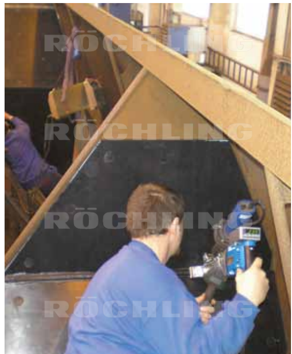
Trabajos de soldadura en el revestimiento de un vagón de mercancías: el revestimiento Matrox® se suelda en los ángulos acodados para evitar la acumulación de material a granel en las esquinas
