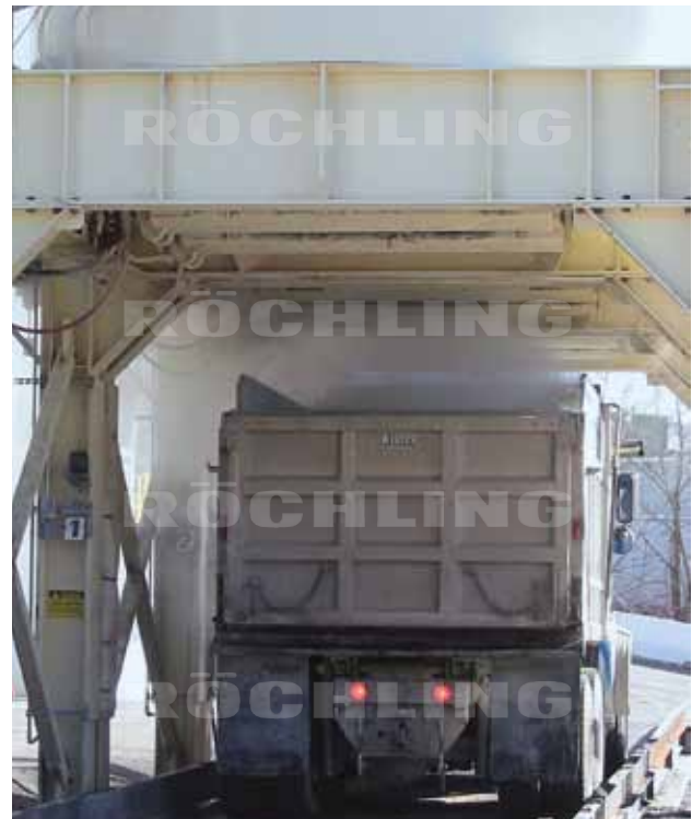
Vaciando un silo: el revestimiento de Matrox® del silo garantiza la descarga uniforme e ininterrumpida del material a granel
